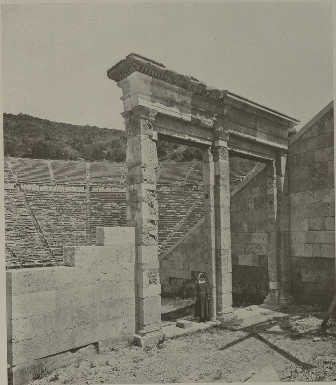
57. EPIDAUROS. THEATER IM HEILIGEN BEZIRK DES ASKLEPIOS. Westlicher Zugang zur Orchestra von außen.
